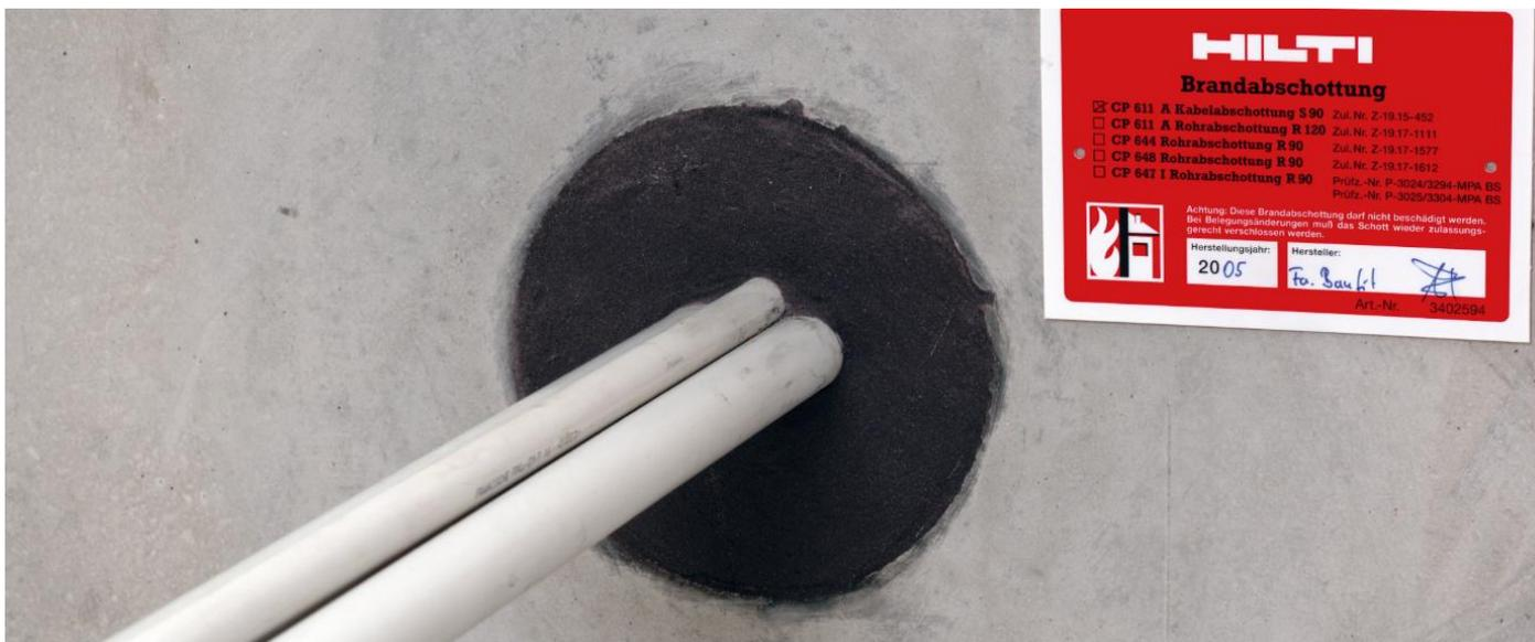
**1.1 ATTRAVERSAMENTI ELETTRICI IN APERTURE DI MASSIMO 150 mm, SIGILLATI CON SIGILLANTE INTUMESCENTE HILTI CFS-IS**
