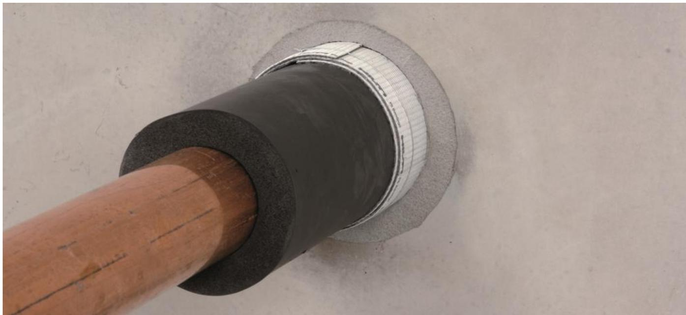
**1.1 ATTRAVERSAMENTI DI TUBAZIONI COIBENTATE CON ISOLANTE COMBUSTIBILE (isolante a celle chiuse) SIGILLATI CON BENDA ANTIFUOCO HILTI CFS-B**
