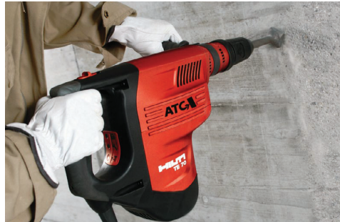
б) Шорсткість поверхні за допомогою інструменту для очищення
