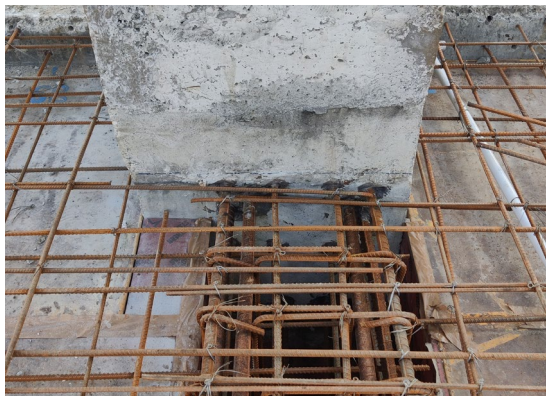
д) З'єднання балки з колоною
