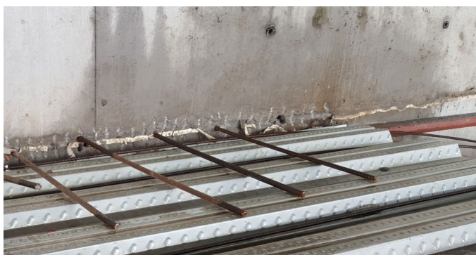
б) Монтаж пост-встановленої арматури для з'єднання плити зі стіною
