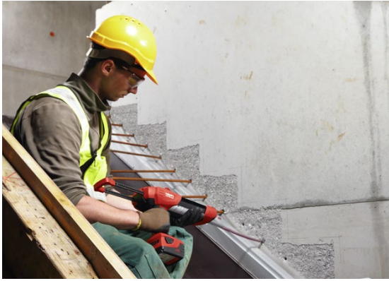
а) З'єднання сходового маршу зі стіною
