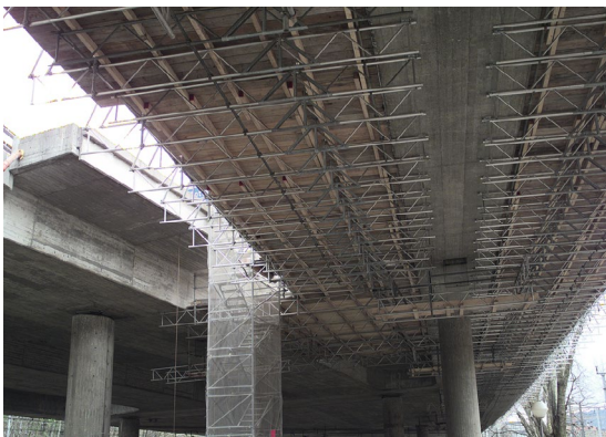
с) Збільшення товщини прогонової балки мосту
