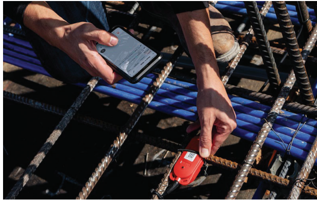
Рис. 9.20 — Бездротовий датчик бетону Hilti, який передає дані в реальному часі про температуру, міцність і відносну вологість у мобільний застосунок Hilti Concrete Sensors.
