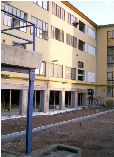
а) Триповерхова промислова будівля
