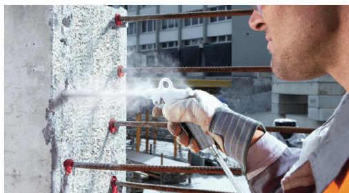
а) Продування пилу з отворів стисненим повітрям
