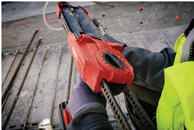
а) Автоматичний дозатор HDE 500-A22 із подовжувальним шлангом
