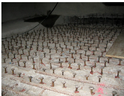
б) Посилення коробчастої балки мосту зсувними з'єднувачами НСС-К
