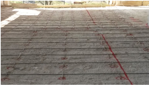
а) Бетонна накладка на існуючих перекриттях
