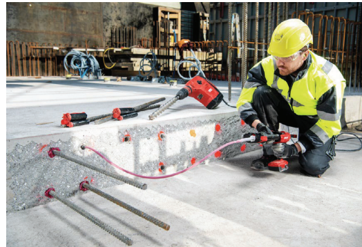
б) Автоматичний дозатор HILTI HDE 500-A22 із подовжувальним шлангом
