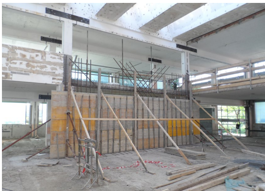
е) Додавання (улаштування) стіни жорсткості
