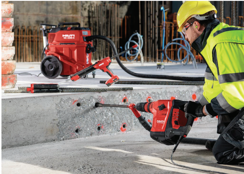
Рис. 9.16 — Система Hilti SafeSet™ — безпилове свердління отворів порожнистими бурами (HDB)
