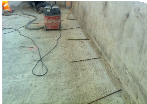
б) З'єднання накладки з периметральними стінами
