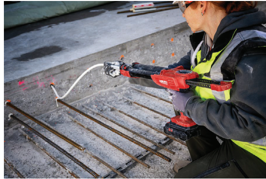
б) Подовжувальний шланг для введення клейового розчину
