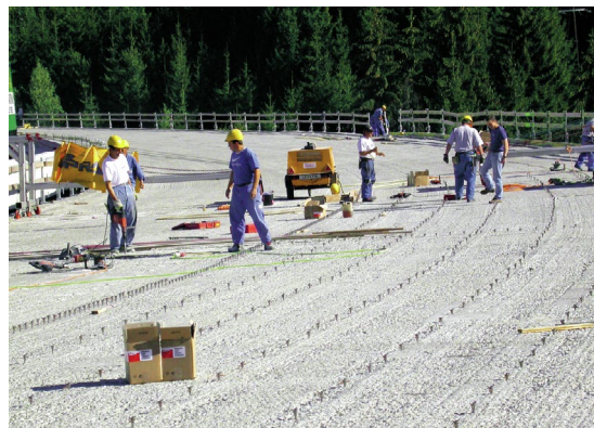
д) Збільшення товщини плити проїзної частини мосту
