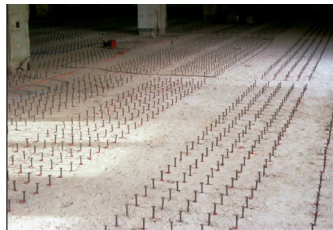
с) Посилення плити із зсувними з'єднувачами НСС-К
