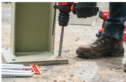
б) Встановлення через елемент
