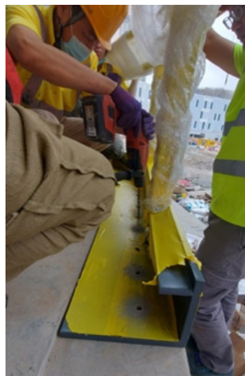
с) Установлення сталевого профілю
