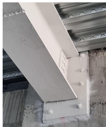
Рис. 6.11 — З'єднання опорної пластини з використанням групи анкерів (4×2)
