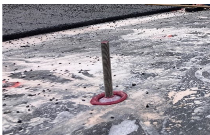
с) Стержень із ущільнювальною кришкою HIW-SD для гідроізоляції
