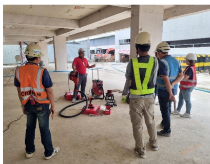
г) Демонстрація на будівельному майданчику
