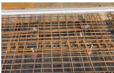
б) Анкери, встановлені в арматурний каркас до бетонування
