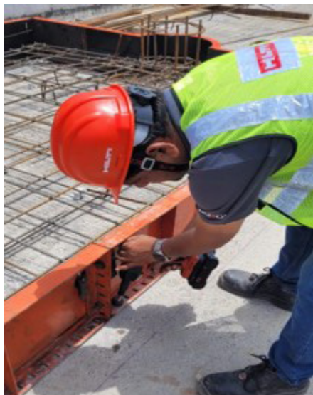
а) Монтаж опорної пластини / фіксація рам опалубки під час будівництва
