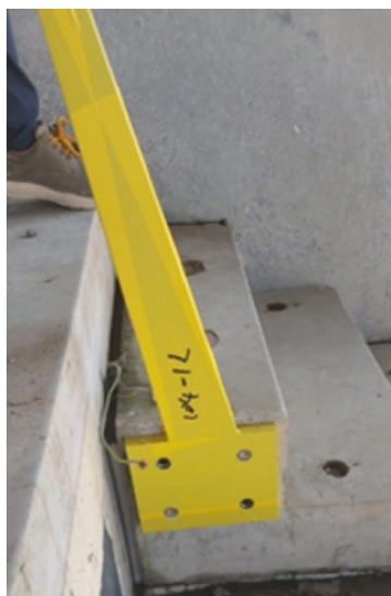
б) Монтаж опорної пластини під час будівництва
