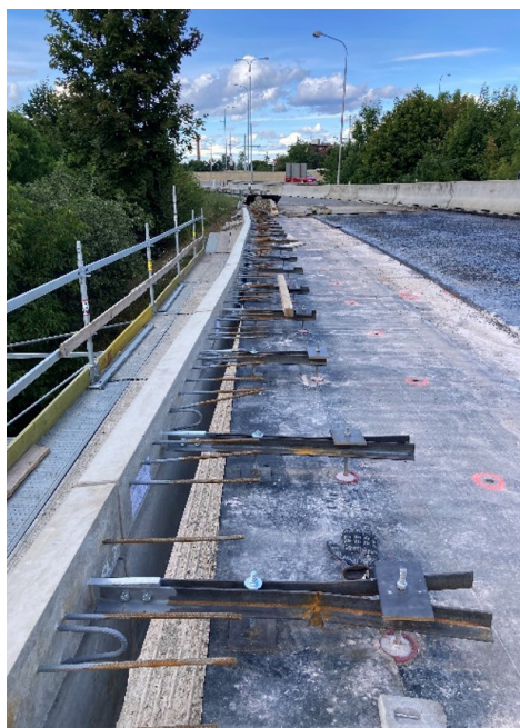
а) Сталеві консолі, закріплені за допомогою анкерів Hilti та клею RE 500 V4
