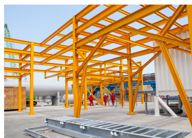
а) Сталева колона конструкції
