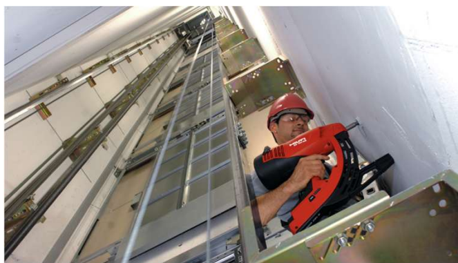
Lắp đặt thiết bị thang máy
