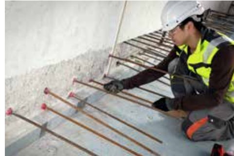
Collegamento solaio-parete
