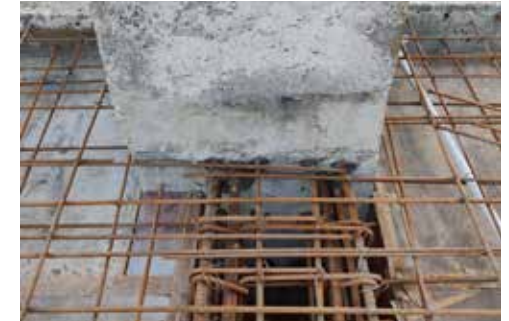
Collegamento trave-pilastro
