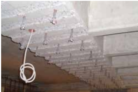
Ringrosso della trave in calcestruzzo armato
