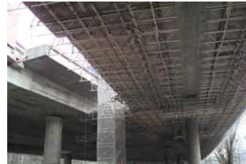
Aumento dello spessore della trave da ponte
