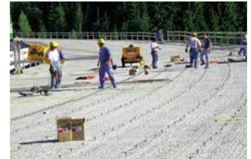
Aumento dello spessore della soletta da ponte
