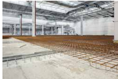
Rinforzo di una pavimentazione industriale
