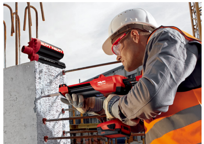
圖2、使用喜利得HDE 500-A12電動注射器將HIT-RE黏著劑注入鑽孔中，以利後置鋼筋的安裝。
