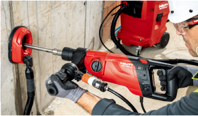
圖25、使用喜利得濕式手持洗孔機與集水技術進行洗孔。
