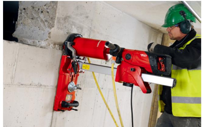
圖24、使用喜利得鑽孔機支架進行斜面洗孔。
