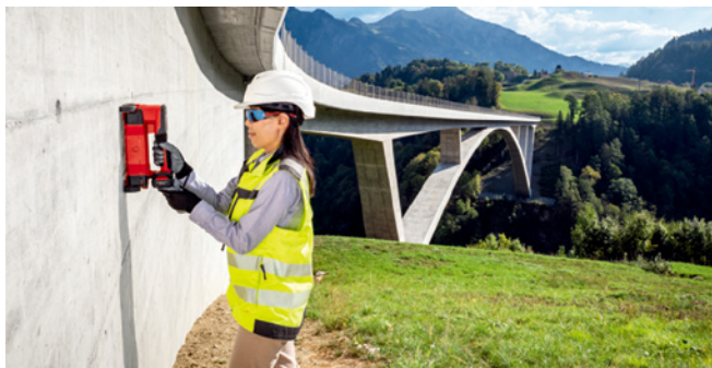
圖5、使用Hilti GPR掃描儀掃描鋼筋及其他埋置元件。
