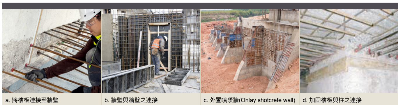
圖6、使用HILTI HIT-RE 500 V3之結構加固應用。
