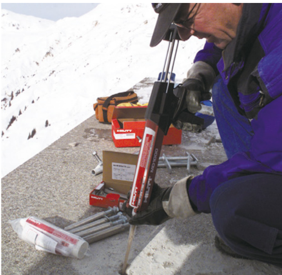
圖1、黏結式錨栓安裝（使用針對低溫情況的Hilti HIT-ICE，瑞士森蒂斯峰(Säntis)）。
