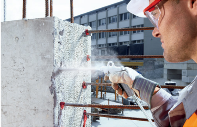
圖32、使用壓縮空氣吹洗工具清潔孔。
