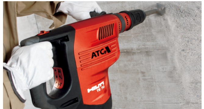
圖22、使用喜利得TE 70-ATC兩用電鎚鑽將混凝土表面粗化。
