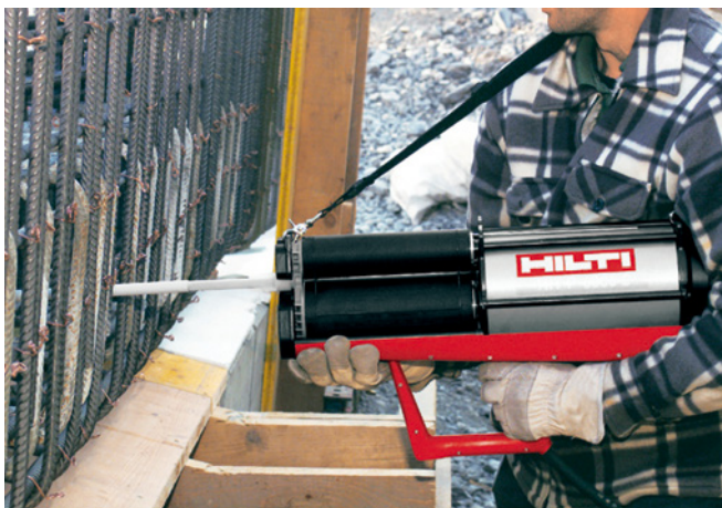
圖36、Hilti HIT-P8000D氣動注射器，適用於大體積安裝及大鋼筋直徑。
