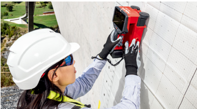
圖21、使用Hilti PS 300手持式鋼筋探測儀在開始鑽孔之前探測並繪製現有鋼筋的位置。
