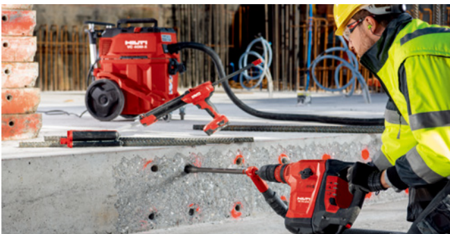
圖26、使用配備Hilti SafeSet™技術之喜利得旋轉衝擊鑽進行鑽孔。
