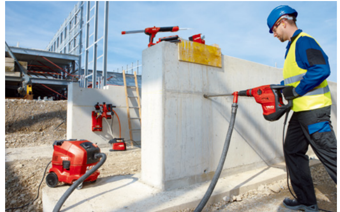
圖30、Hilti SafeSet™系統搭配空心鑽頭(HDB)及吸塵器。
