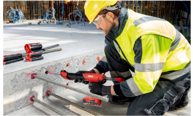
圖34、針對較小的鋼筋直徑，將Hilti HIT-RE 500 A22充電式黏著劑 注射器與Hilti HIT-RE 500 V3／Hilti HIT-HY 200 V3搭配使用。
