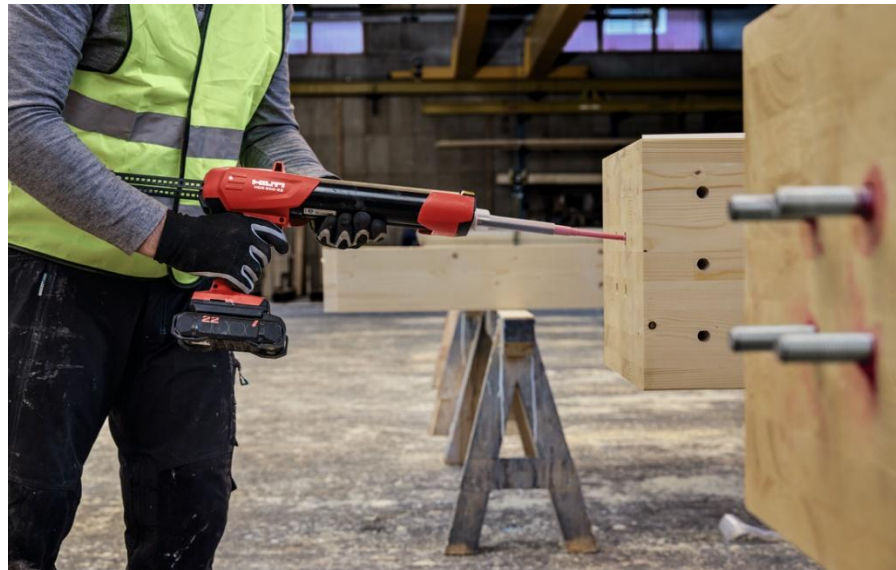
Abb. 2.1: Hilti HIT-RE 500 V4 Verklebte Ankerstangen
