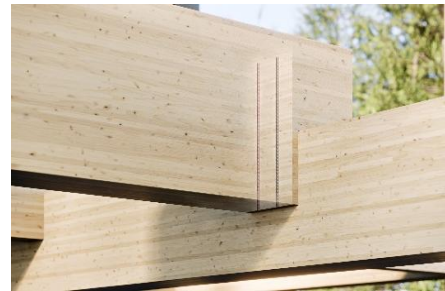
b) Verstärkung von Kerben
