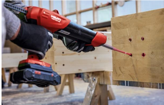
Abb. 2.5: Hilti GiR-Montage mit direkter Befüllung
