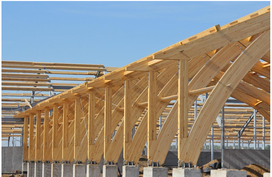
Abb. 1.1: Beispiel für Ingenieurholz-Untergrundmaterialien im Tragwerk eines Gebäudes
