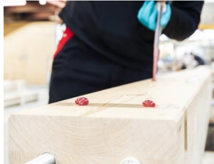
Abb. 2.3: Hilti GiR-Montage mit Bypass-Befüllung
