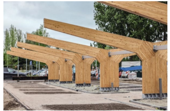
Bild 5: Montage einer tragenden Holz-Stahl-Verbindung mit eingeklebten Gewindestangen auf einem Betonfundament. Bild 6: Hebevorgang der biegesteifen BSH-Tragstützen aus Lärchenholz, bevor die eingeklebten Gewindestangen am Stahlfuß mit Muttern gekontert werden. Bild 7: Holztragwerk in der Montagephase mit wiederkehrenden Rahmen und Stahlanschlüssen auf Betonfundamenten.
