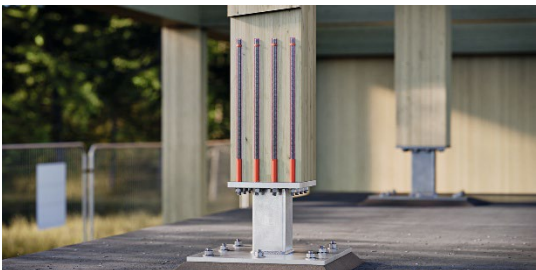
Bild 8: Biegesteifer Stützenfuß unter Verwendung von Verbundlosen-Hülsen und Zentrierringen. Bild 9: Stahl-Holz-Fachwerkknoten unter Verwendung von Verbundlosen-Hülsen und Zentrierringen.
