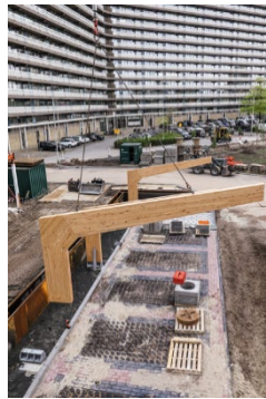
Bild 5: Montage einer tragenden Holz-Stahl-Verbindung mit eingeklebten Gewindestangen auf einem Betonfundament. Bild 6: Hebevorgang der biegesteifen BSH-Tragstützen aus Lärchenholz, bevor die eingeklebten Gewindestangen am Stahlfuß mit Muttern gekontert werden. Bild 7: Holztragwerk in der Montagephase mit wiederkehrenden Rahmen und Stahlanschlüssen auf Betonfundamenten.
