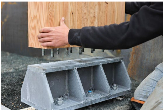
Bild 5: Montage einer tragenden Holz-Stahl-Verbindung mit eingeklebten Gewindestangen auf einem Betonfundament. Bild 6: Hebevorgang der biegesteifen BSH-Tragstützen aus Lärchenholz, bevor die eingeklebten Gewindestangen am Stahlfuß mit Muttern gekontert werden. Bild 7: Holztragwerk in der Montagephase mit wiederkehrenden Rahmen und Stahlanschlüssen auf Betonfundamenten.
