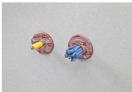
Datové a telekomunikační kabely
