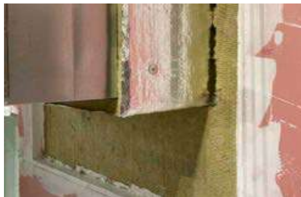
Měkká požární ucpávka tvořená tuhou minerálně-vláknitou deskou (objemová hmotnost 150 kg/m 3 ), která je usazena do požárního akrylátového tmelu
