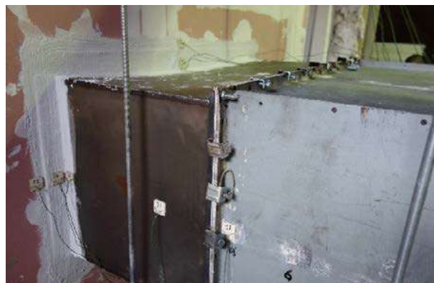
Pohled na detail těsnění prostupu VZT potrubí s požární klapkou z druhé strany, tedy na neohřívané straně (vně pece)
