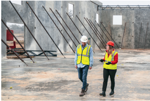
Тимчасова опора для стіни
