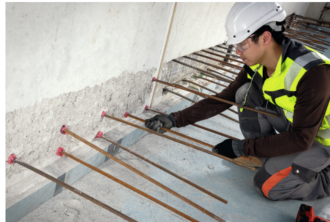
З'єднання плити зі стіною
