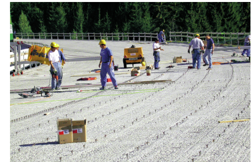
Збільшення товщини плити прогону мосту
