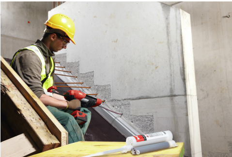
З'єднання сходів зі стіною
