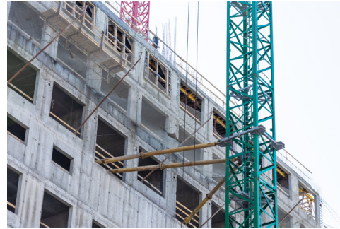
Опора для баштового крана
