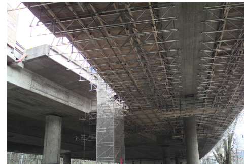
Збільшення товщини балки моста
