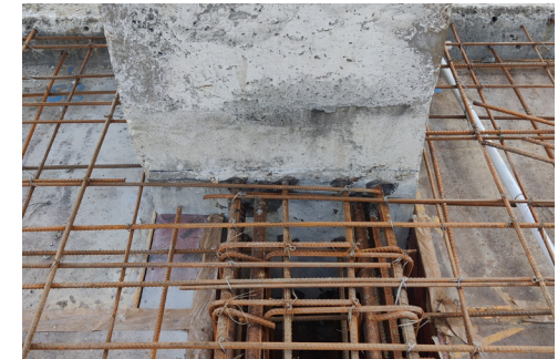
З'єднання балки з колоною
