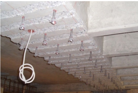
Збільшення глибини армованої балки
